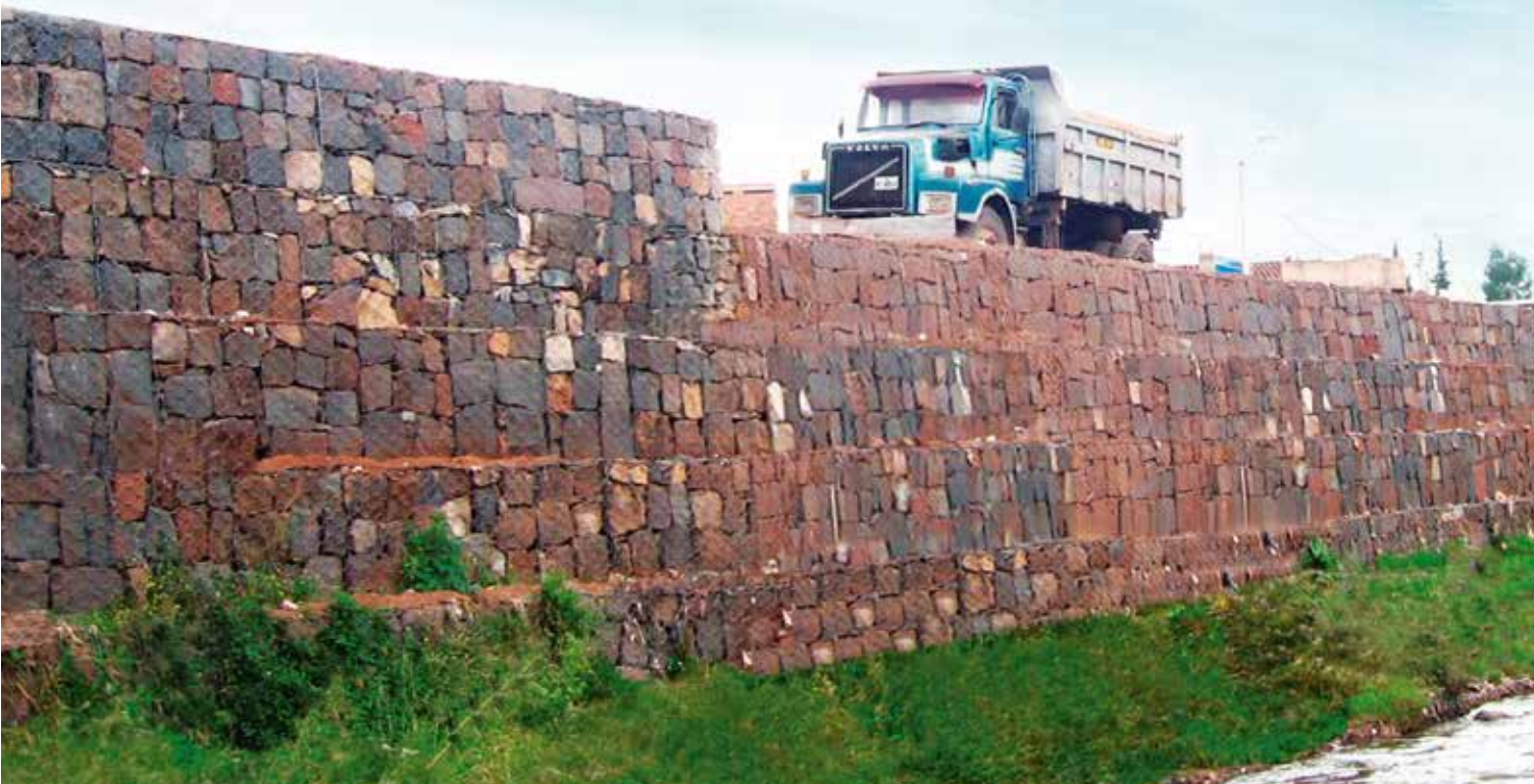
Gavión de suelo reforzado como muro de contención.
