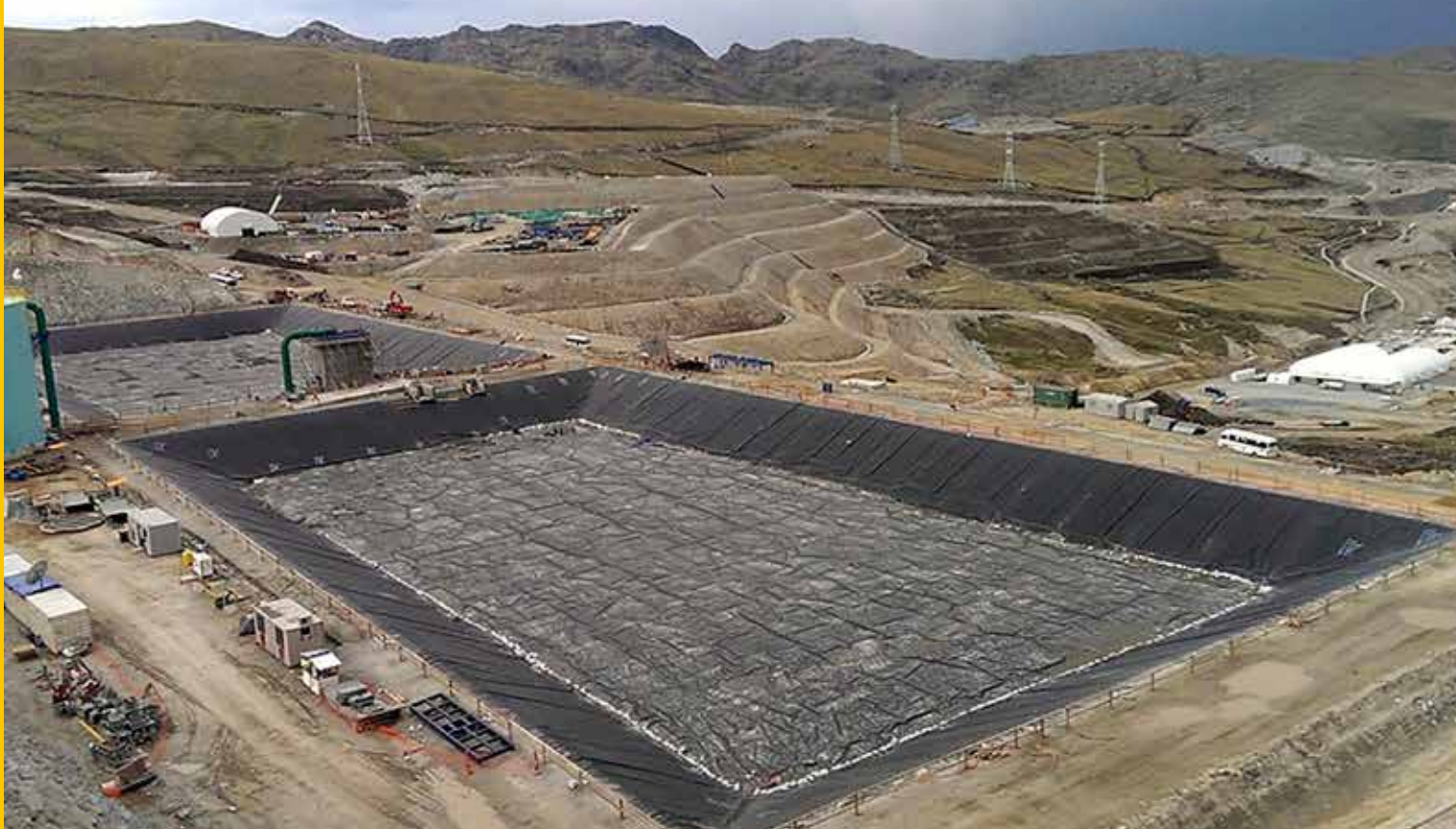
Depósito de residuos.
