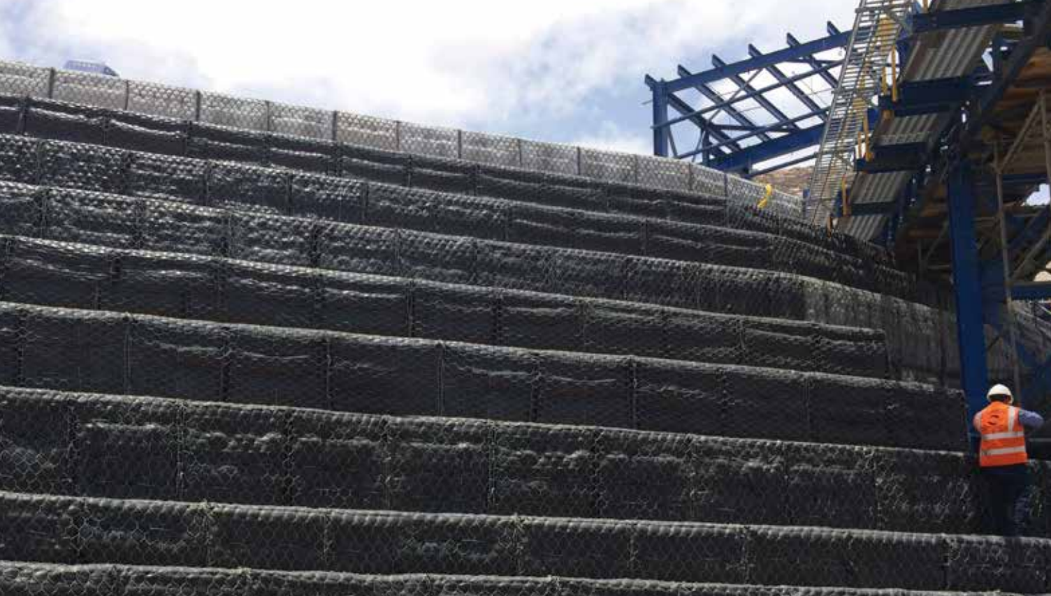
Sistema Gavión Tex como muro de contención.
