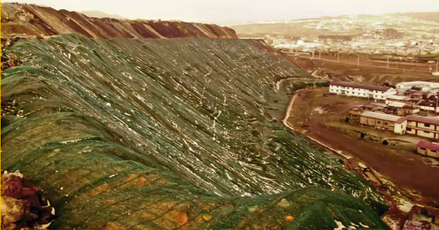
Protección superficial de talud con manto permanente.
