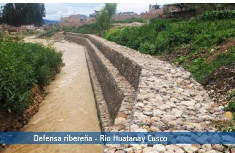
Gavión de suelo reforzado para ampliación de plataforma.
