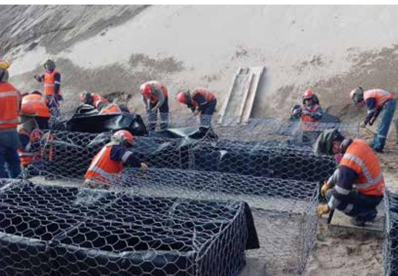
Armado del Gavión Tex.
