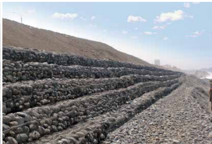
Gavión Grid como muro de contención.
