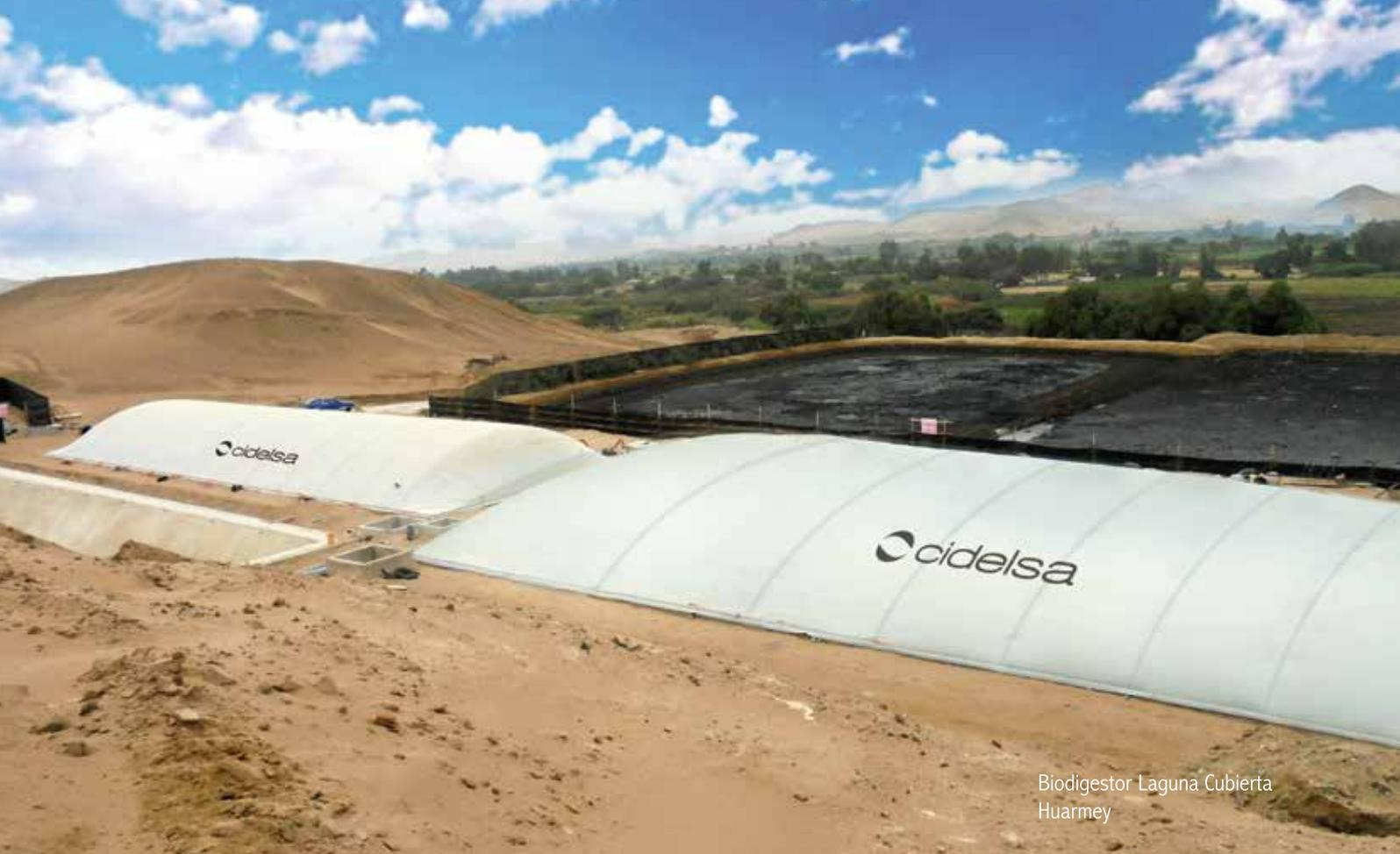
Biodigestor Laguna Cubierta
