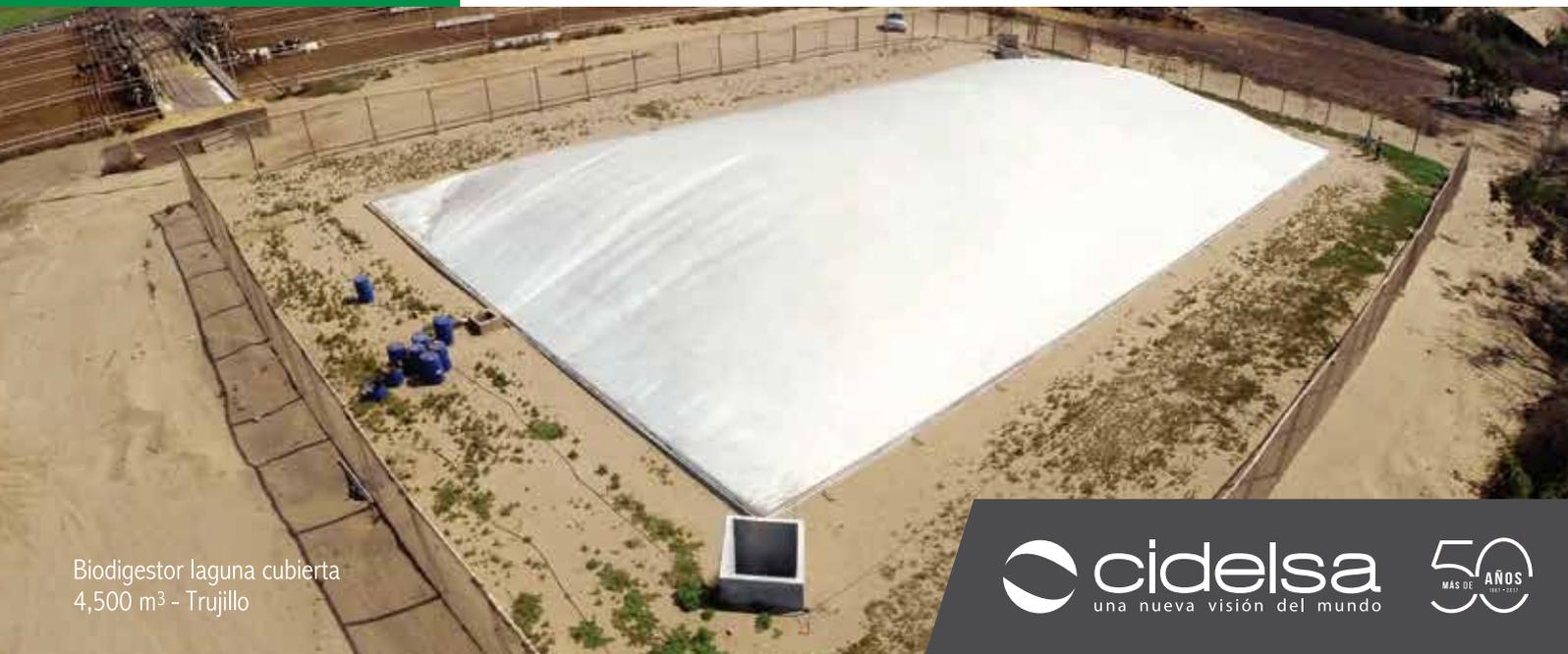
Biodigestor laguna cubierta
